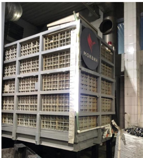
Рис. 1.4. Емкость марки ГСГ 6000-2800 из полипропилена с полезным объемом 18 м 3
