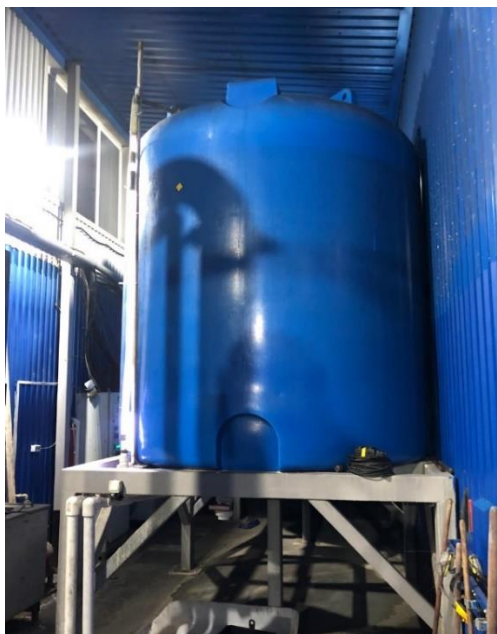
Рис. 1.5. Емкость марки TR 10000 из полиэтилена с полезным объемом 10 м 3
